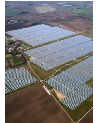
Einer der weltgrößten Solarparks (54 MWp), Gänsdorf
